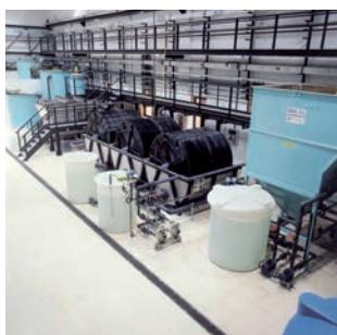
Diseñada y construida por la empresa Depuración Ibérica de Aguas (D.E.I.D.A), trata las aguas negras que se producen en el Campus, formada por un tratamiento físico-químico, tratamiento biológico-biodiscos, tratamiento terciario de filtración y desinfección, y línea de fangos, con un caudal medio diario de depuración de 150 m<sup>3</sup>.
