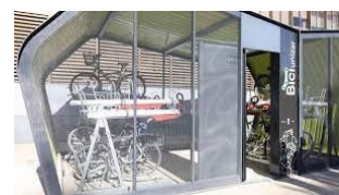
Aparcamiento de bicicletas del campus de San Francisco (Universidad de Zaragoza)
