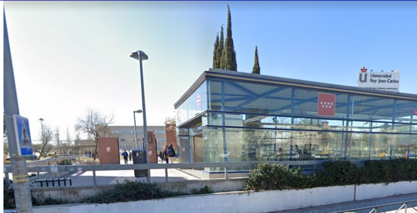
Acceso peatonal desde el metro del campus de Fuenlabrada
