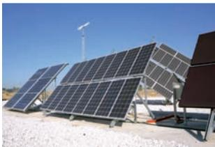
Esta zona está formada por tres estructuras metálicas capaces de alojar 1360 vatios de módulos fotovoltaicos cada una. Las estructuras están ancladas sobre zapatas, orientadas al sur y su inclinación es regulable entre 25 y 65 grados. Cada una de las tres estructuras dispone de: silicio monocristalino, policristalino y amorfo, contando con un inversor independiente para cada una de ellas, que está montado en el centro de control.
